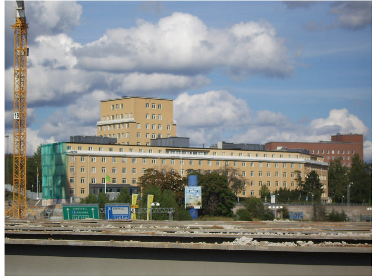
Norrbacka sett från f. d. Solnabron den 3 september 2011 när rivningen har skett.
