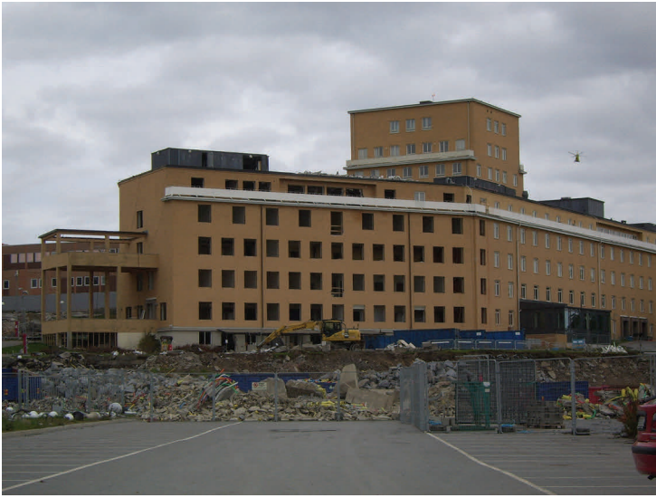
Den västra delen av Norrbacka den 10 oktober 2010 vid början av rivningen.
