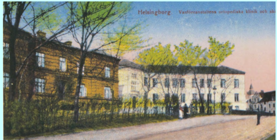
Vanföreanstalten i Helsingborg med tillbyggnaden till höger i bilden
